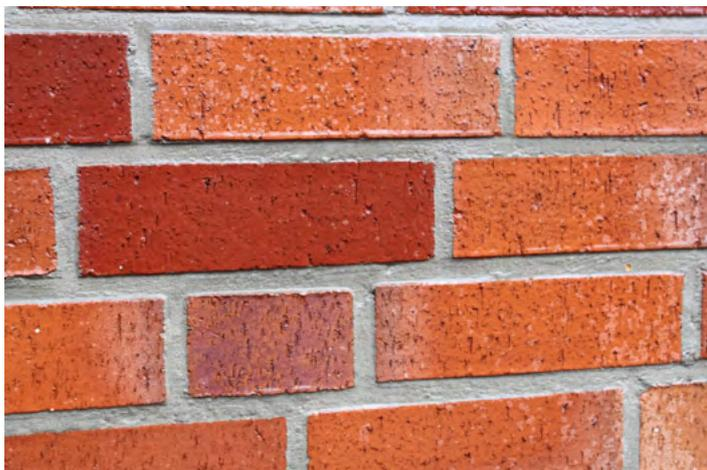
**Abb.1** Unbehandelte Fassade. Wasser wird vom Baustoff aufgenommen.
